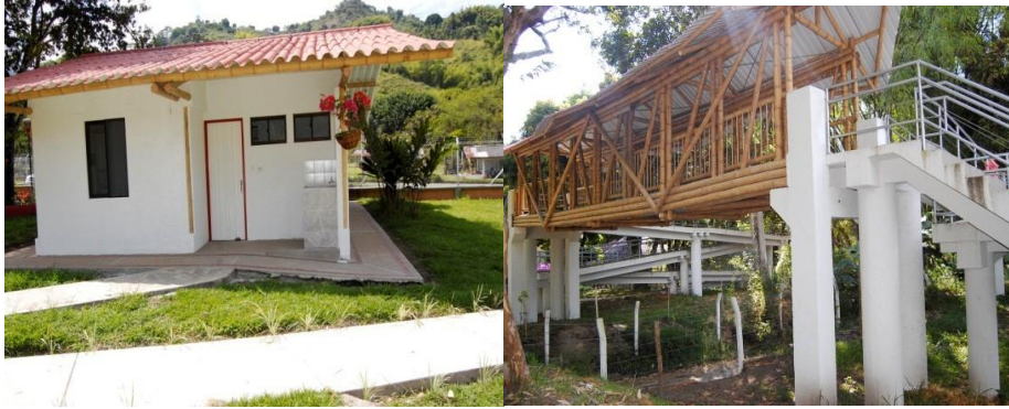
Modelos de construcciones de viviendas y puente con guadua en el Cnebg
